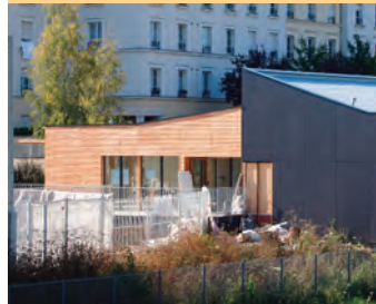
Accueil périscolaire Serris (Seine-et-Marne)
