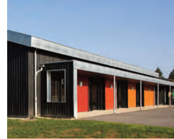
Accueil périscolaire Chauray (Deux-Sèvres)
